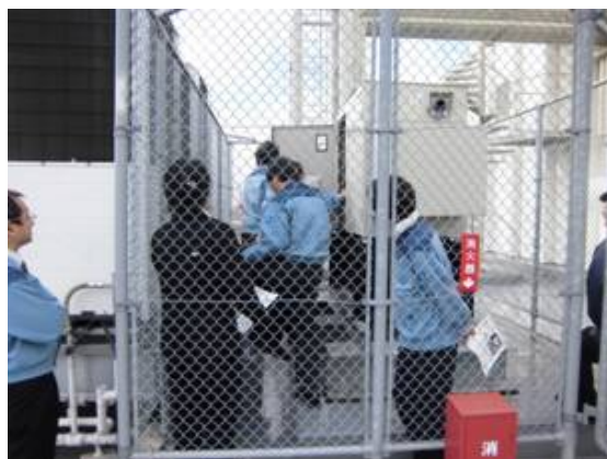
予備発電機起動訓練を行う職員
