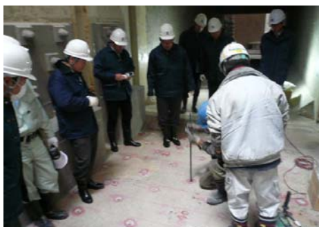
地下水槽(底部)での鉄筋挿入の施工状況
