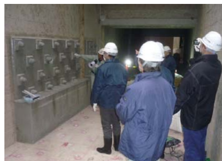
地下水槽(壁面)への鋼板接着した施工を説明
